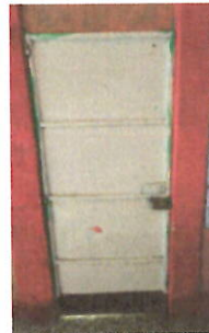
Foto 4: PUERTAS Mantenimiento a puerta metálica existente retiro de óxido, suciedad y pintura deteriorada; incluye cepillado, lijado y aplicación de pintura
