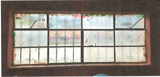
Foto 1: VENTANAS Sustitución de ventanas; sistema de apertura: Corredizas, Perfiles color blanco estandar, Material del marco: PVC Material de la ventana: Vidrio, sellado perimetral.
