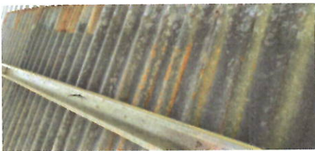
Foto 5: CUBIERTA DE LAMINA Sustitución de cubierta de techo con lámina galvanizada, Tipo de lamina: troquelada Calibre: 26, incluye: fijaciones y sellado en traslapes. En cancha y cocina
