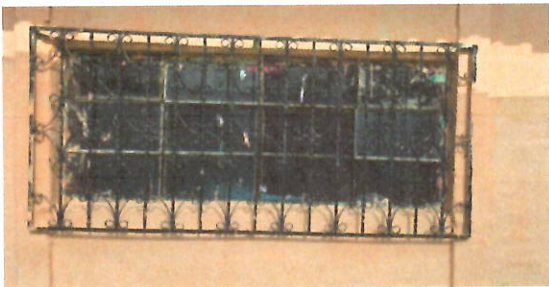
Foto 3: VENTANAS Sustitución de balcones metálicos, incluyendo fijaciones, pintura y soldaduras
